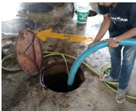
ภาพที่ 4-33 ดูตะกอนบ่อเกรอะและบ่อกักตะกอนที่ระบบบำบัดน้ำเสีย
