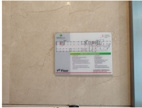
ภาพที่ 4-20 ป้ายแบบแปลนแสดงจุดที่ตั้งอุปกรณ์ดับเพลิงและเส้นทางหนีไฟบริเวณโถงลิฟต์
